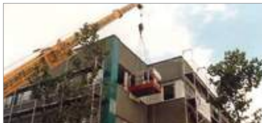
доставка краном h/p/cosmos saturn®
